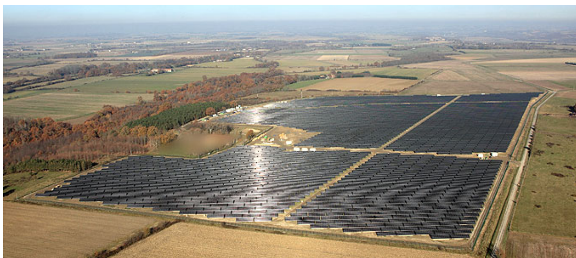
Le parc photovoltaïque de Saint Amadou – Source Ariegenews
